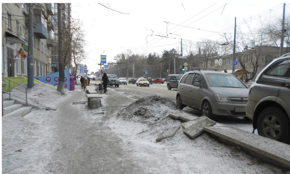
Рис. 2. Расширение проезжей части за счет газона и тротуара с переносом остановки. После строительных работ вертикальная планировка и замощение нарушены
