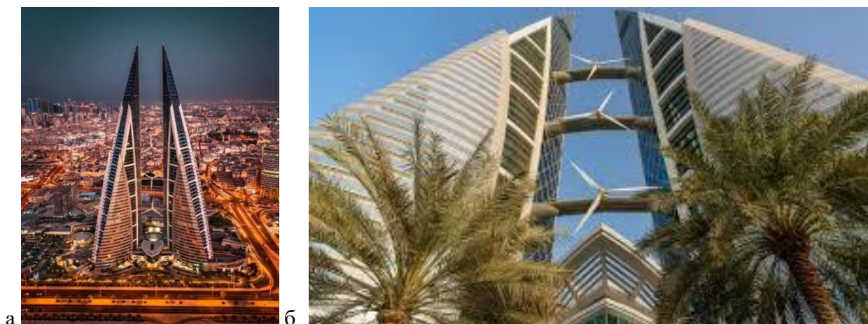
Рис. 2. Всемирный торговый центр в г. Манаме, Бахрейн: а – общий вид; б – вид на верхнюю часть с ветряными турбинами
