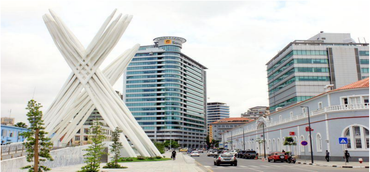
Рис. 4. Общий вид здания «Sonangol», г. Луанде, Ангола
