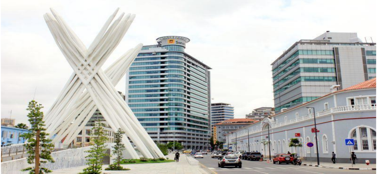
Рис. 4. Общий вид здания «Sonangol», г. Луанде, Ангола
