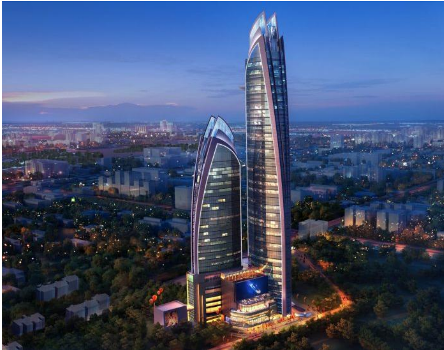
Рис. 2. Общий вид «Башни Пиннакл» в г. Найроби, Кения
