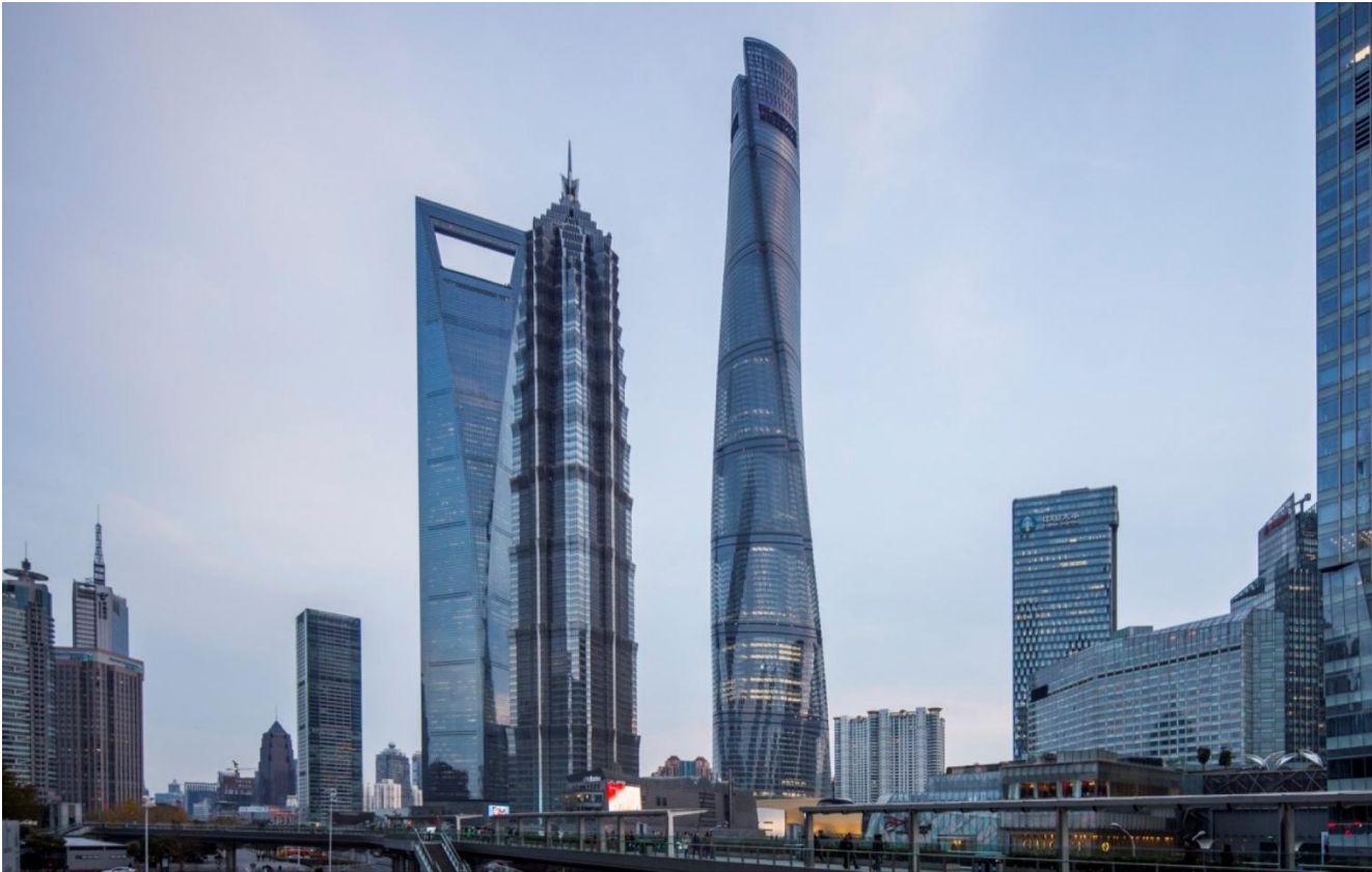
Рис. 5. Общий вид Шанхайской башни в г. Шанхае, Китай
