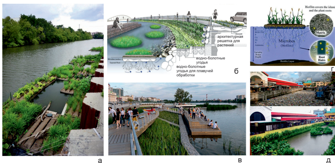
Рис. 3. Экологически устойчивые методы организации контактных набережных с использованием биоинженерии и растительных решений: а – водно-болотные угодья на плавучих островах на реке Чикаго, которые представляют собой серию плавучих садов, установленные для укрепления популяции местных диких животных (сегодня острова являются процветающей средой обитания местной рыбы и водоплавающих птиц); б – пример организации набережных на основе биоинженерии и растительных решений; в – набережная озера Кабан в г. Казани, 2018 г. (отличительная особенность – создана система фильтрации воды с помощью растений); г – фитоочистная система с использованием искусственных плавучих островов; д – пример очистки канала Пако в г. Манила, Филиппины (плавучие сады площадью примерно 110 кв. м способны отфильтровать загрязнения без применения каких-либо химикатов).
