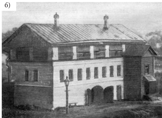
Рис. 2. Типичный набойный корпус 1810-х гг. с сушилами в селе Иваново: а – план 2-го этажа, б – внешний вид
