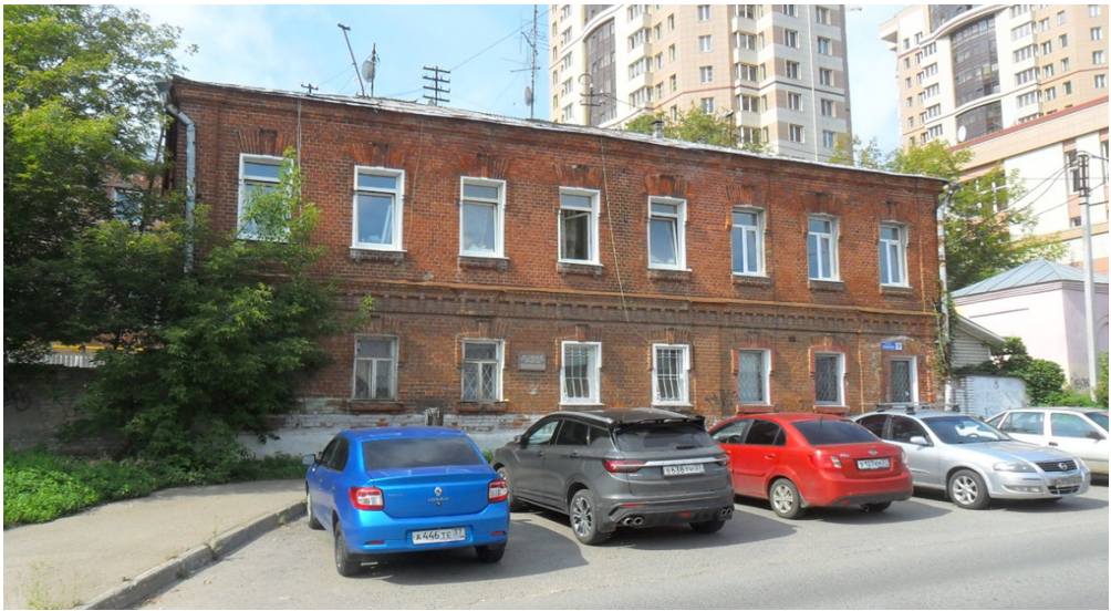
Рис. 5. Дом служащих фабрики Ямановского, вид с улицы Зверева
