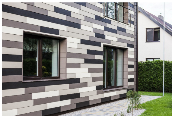
Рис. 5. Фрагмент фасада из пластиковых панелей
