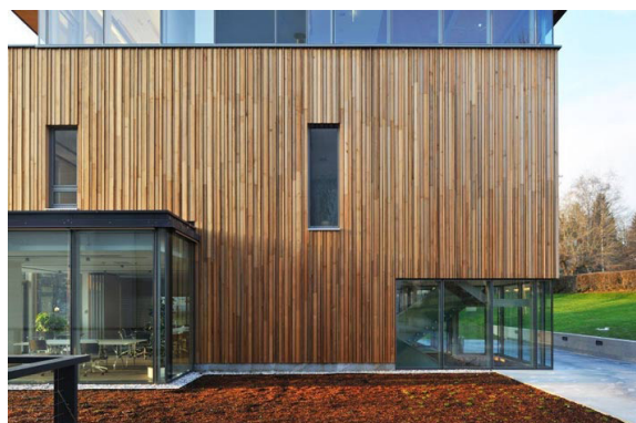
Рис. 4. Фрагмент фасада из деревянных панелей
