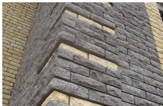
Рис. 1. Фрагмент фасада из облицовочного кирпича
