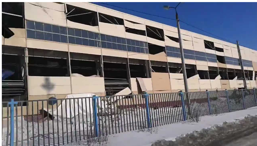
Рис. 4. Поврежденный фасад здания цеха Челябинского трубопрокатного завода (источник http://www.youtube.com )
