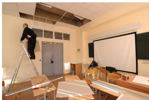
Рис. 8. Ремонт и восстановление школы города Челябинска (источник http://koretsky.livejournal.com ): а) демонтаж деревянных конструкций окон и разбитого остекления; б) частичная замена подвесного потолочного покрытия
