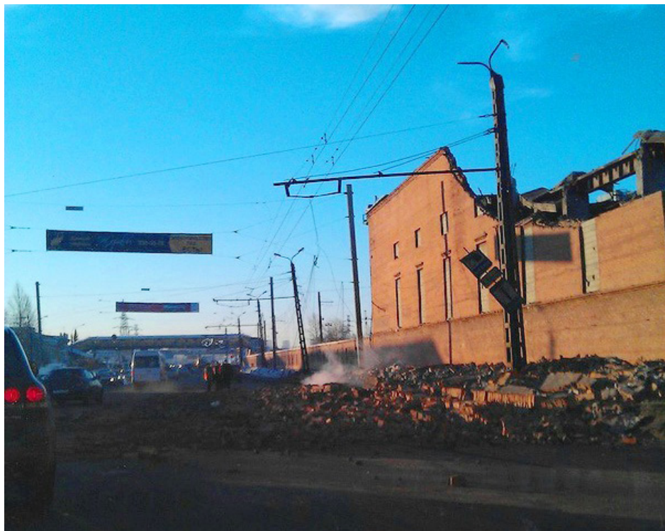
Рис. 3. Вид на частично обрушенное здание цеха Челябинского цинкового завода со стороны Свердловского проспекта (источник http://bigpicture.ru )
