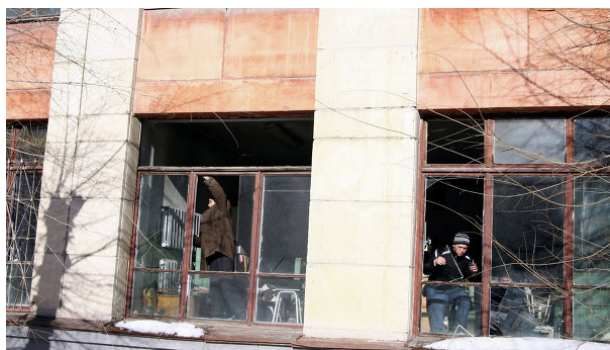
Рис. 8. Ремонт и восстановление школы города Челябинска (источник http://koretsky.livejournal.com ): а) демонтаж деревянных конструкций окон и разбитого остекления; б) частичная замена подвесного потолочного покрытия
