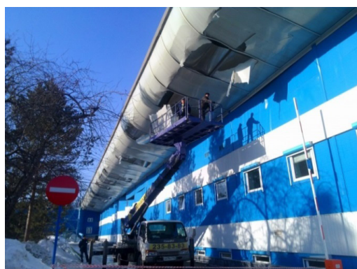
Рис. 7. Деформация ограждающих конструкций Ледового дворца «Уральская молния» (источник http://supercoolpics.com ):
