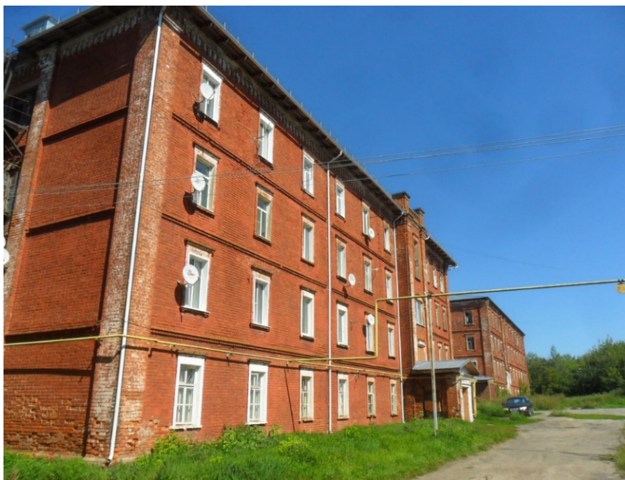
Рис. 3. Западная рабочая казарма. Вдали – восточная. Южный фасад
