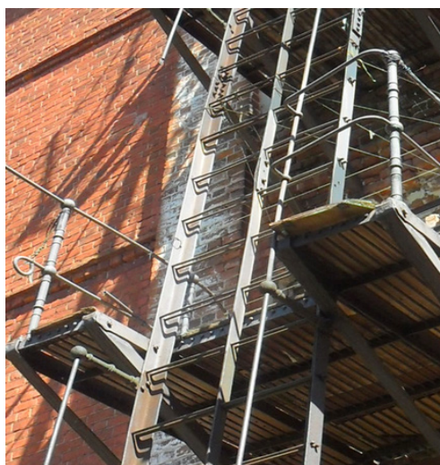
Рис. 4. Лестница на торцевом западном фасаде
