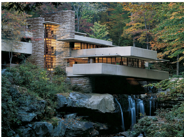
Рис. 5. Дом над водопадом в окрестностях г. Питтсбурга
