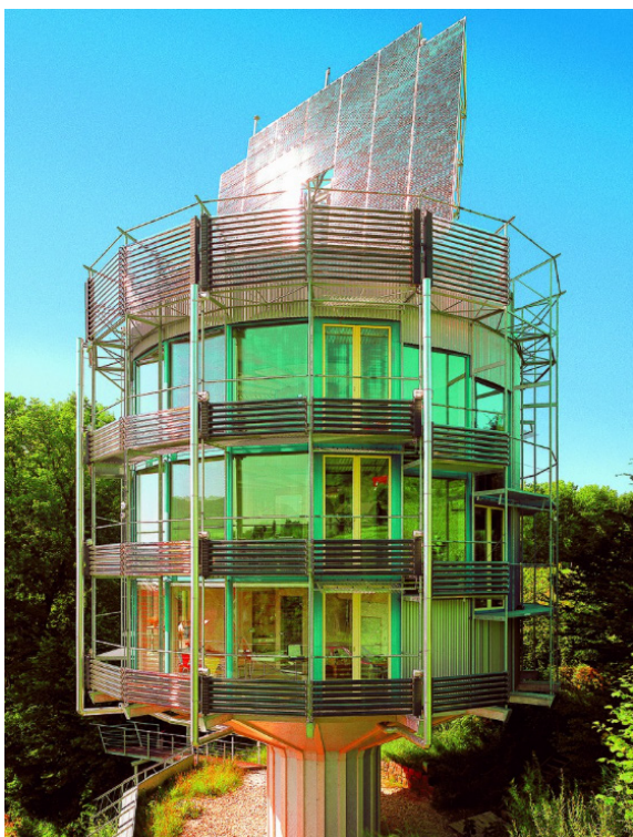
Рис. 3. Здание в стиле активного солнечного дизайна с фотоэлементами на крыше
