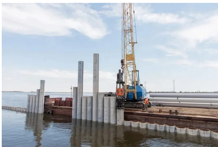
Рис. 2. Монтаж свай-оболочек
