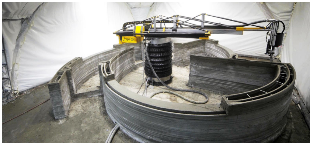
Рис. 5. Процесс печатания дома площадью 38 кв. м
