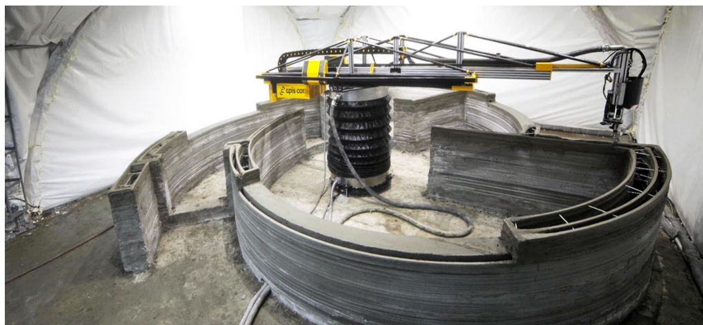
Рис. 5. Процесс печатания дома площадью 38 кв. м
