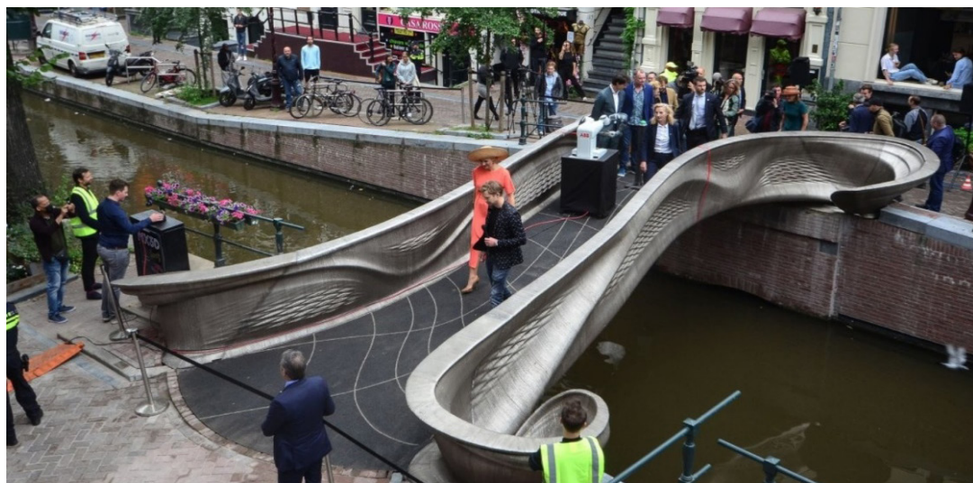
Рис.2. Открытие первого в мире распечатанного на 3D-принтере стального пешеходного моста
