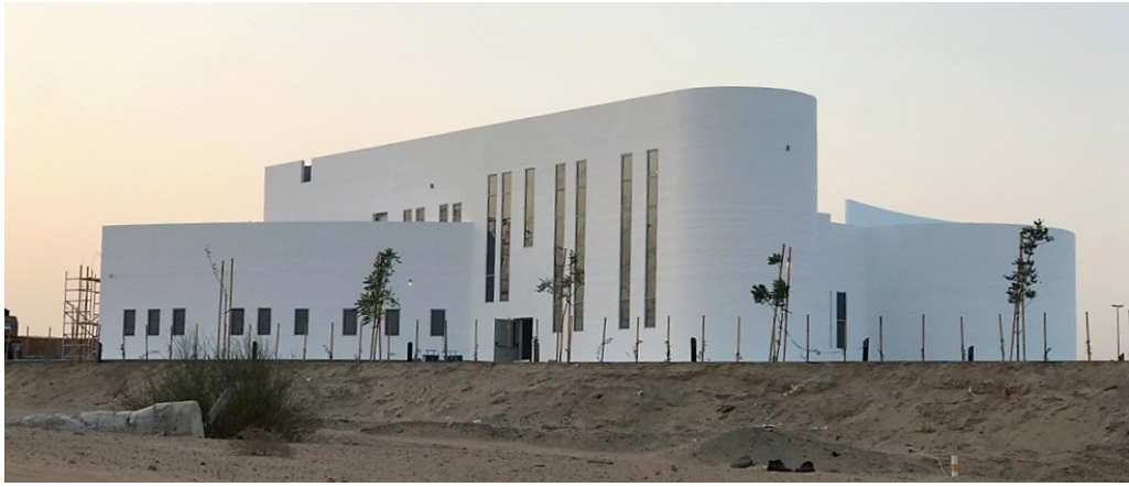
Рис. 6. Общий вид напечатанного дома площадью более 600 кв.м., ОАЭ, Дубай
