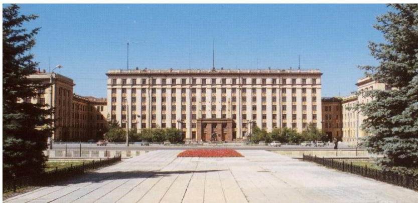
Рис.1. Основной фасад главного корпуса университета до реконструкции при дневном восприятии
