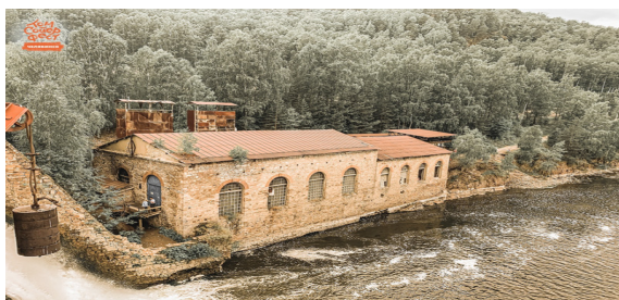
Рис.4. Вид сверху на машинный зал ГЭС «Пороги»
