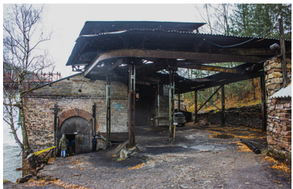
Рис. 5. Фрагмент входа в машинный зал ГЭС «Пороги»
