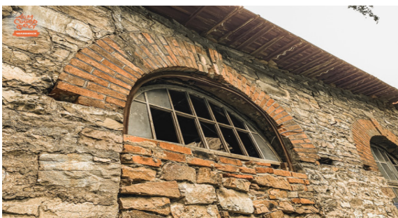
Рис.2. Фрагмент фасада ГЭС «Пороги»
