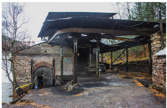
Рис. 5. Фрагмент входа в машинный зал ГЭС «Пороги»
