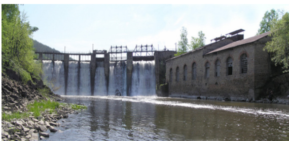
Рис.1. Вид спереди на ГЭС «Пороги»
