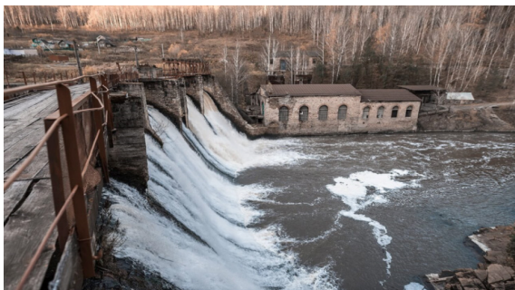
Рис.3. Вид сбоку на ГЭС «Пороги»
