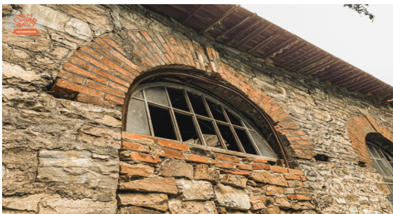
Рис.2. Фрагмент фасада ГЭС «Пороги»
