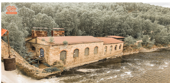
Рис.4. Вид сверху на машинный зал ГЭС «Пороги»
