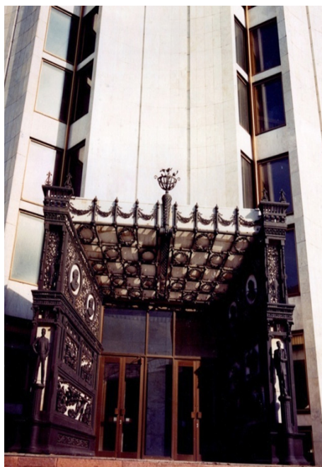
Рис. 4. Портал главного входа Челябинского драмтеатра (фото автора)
